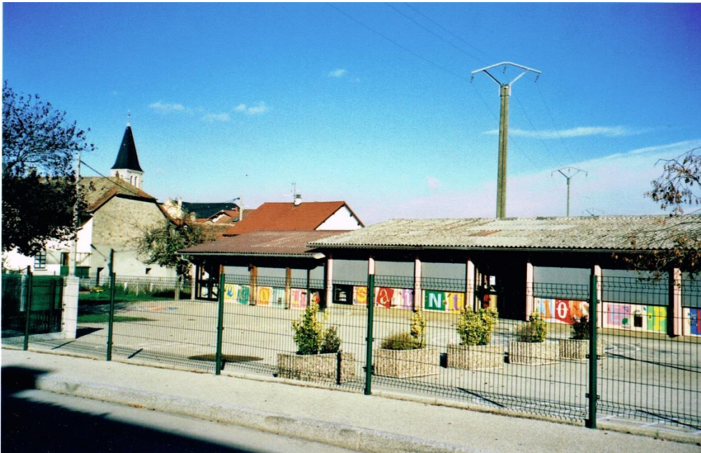
La construction de 1973 avec à sa gauche la nouvelle classe construite (1987)
